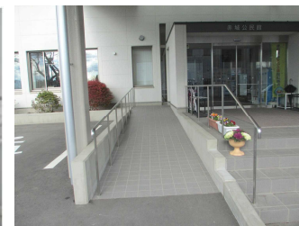
出入口の段差解消 事業費：30万円程度
