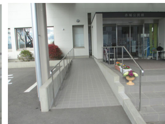
出入口の段差解消 事業費：30万円程度
