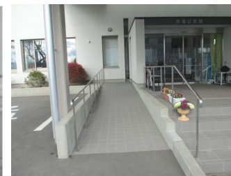
出入口の段差解消 事業費：30万円程度
